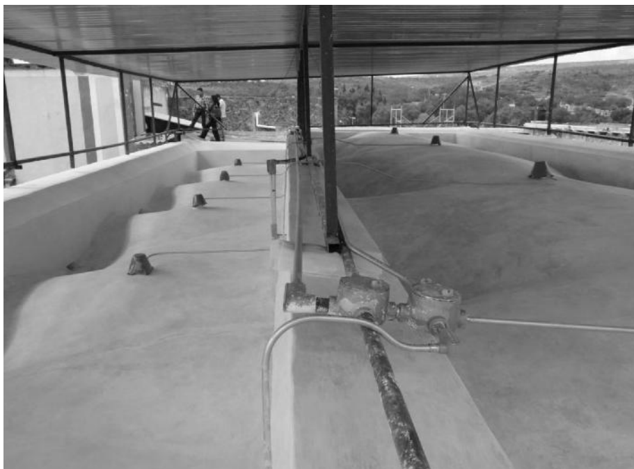
Resultado Cambio de cubiertas: 2016
