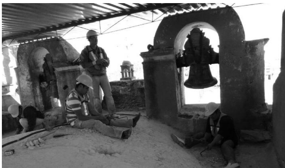
Proceso del cambio y restauración de cubiertas: 2015
